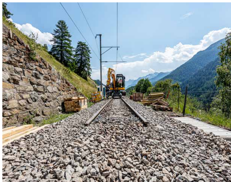
Investition in die Zukunft: Gleiserneuerungen beim Bahnhof Guarda.
