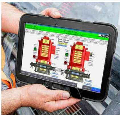
Steuerung der gesamten Kraftwerkanlage per Tablet-Computer.
